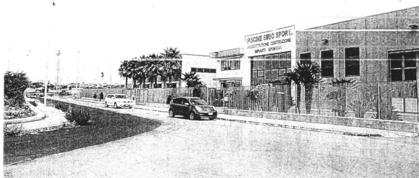
La zona artigianale di Modica sarà interessata a lavori di ampliamento
